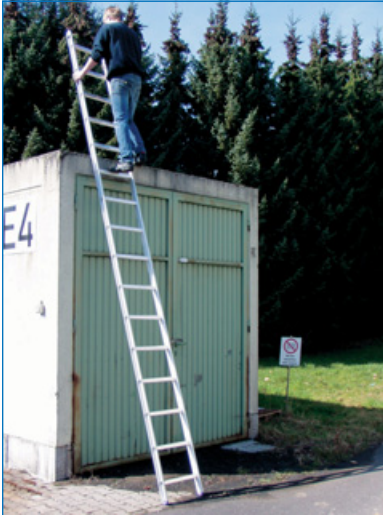
Bild: 40. Übersteigen von der Anlegeleiter
