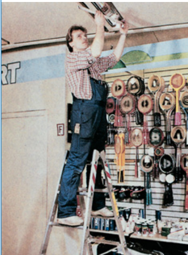
Bild: 44. Sicherer Stand bei Über-Kopf-Arbeiten
